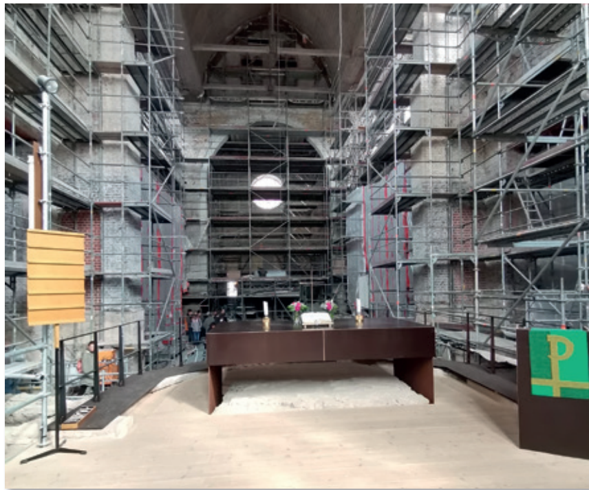
Baustelle Kirche: Auch, wenn äußerlich vieles kaputt ist – das Zentrum bleibt: Altar mit Bibel und Kreuz im Alten Dom St. Johannes Mainz.
